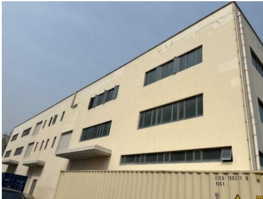
厂房外部现状照片
