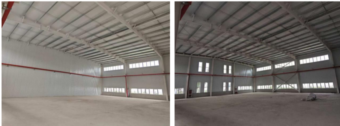
图 2-5 本项目租用厂房现状
