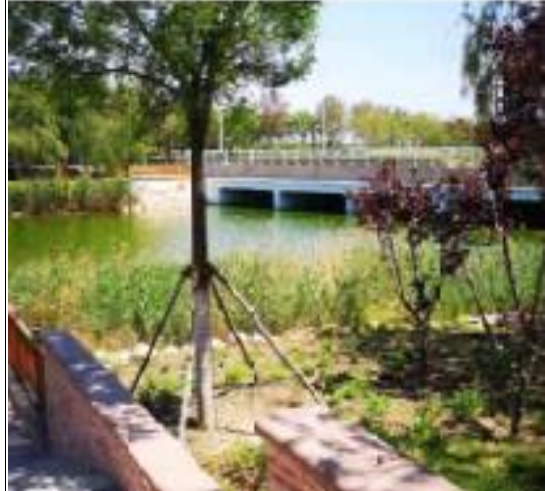
新城住宅段雨水排口现状
