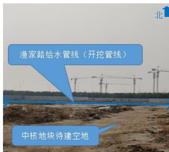
图 1-2 渔家路管线选址现状图 (拍摄日期：2019.06.12)
