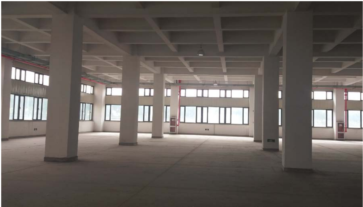
图 1 项目现状为空厂房
