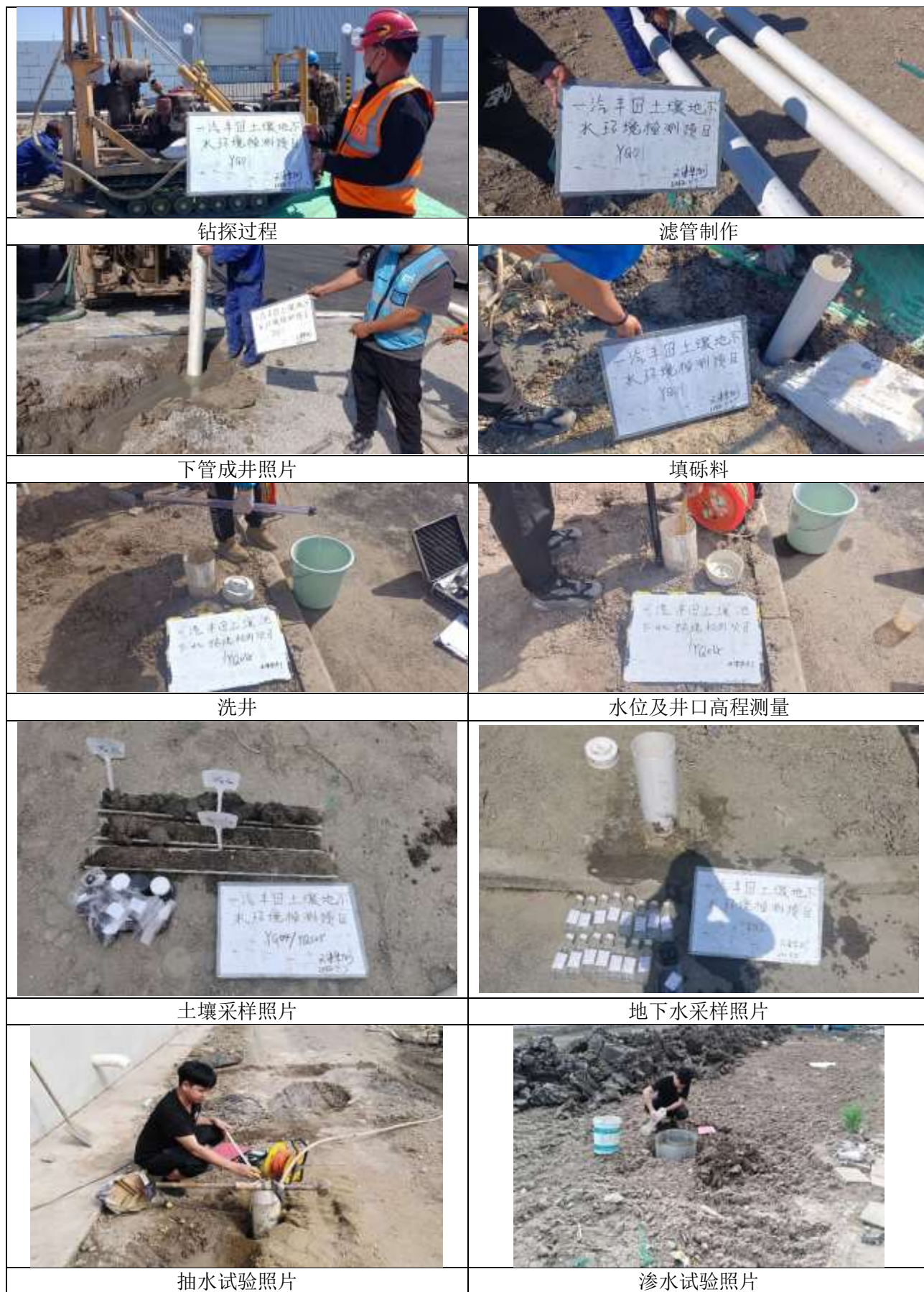
照片 4.2-1 水文地质钻探施工、抽水试验
